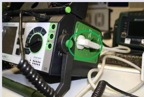
Anschluss des Prüflings
